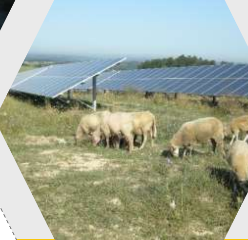
Mise en service
