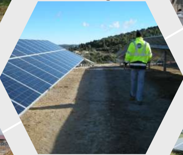
Pose des modules et contrôle de l'alignement
