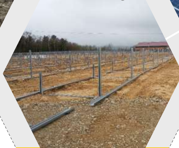
Préparation des structures et rangées
