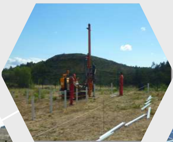
Pose des pieux battus
