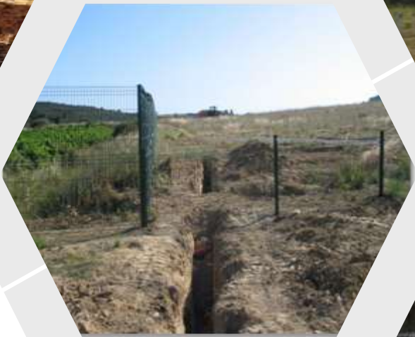
Tranchées pour passage des câbles
