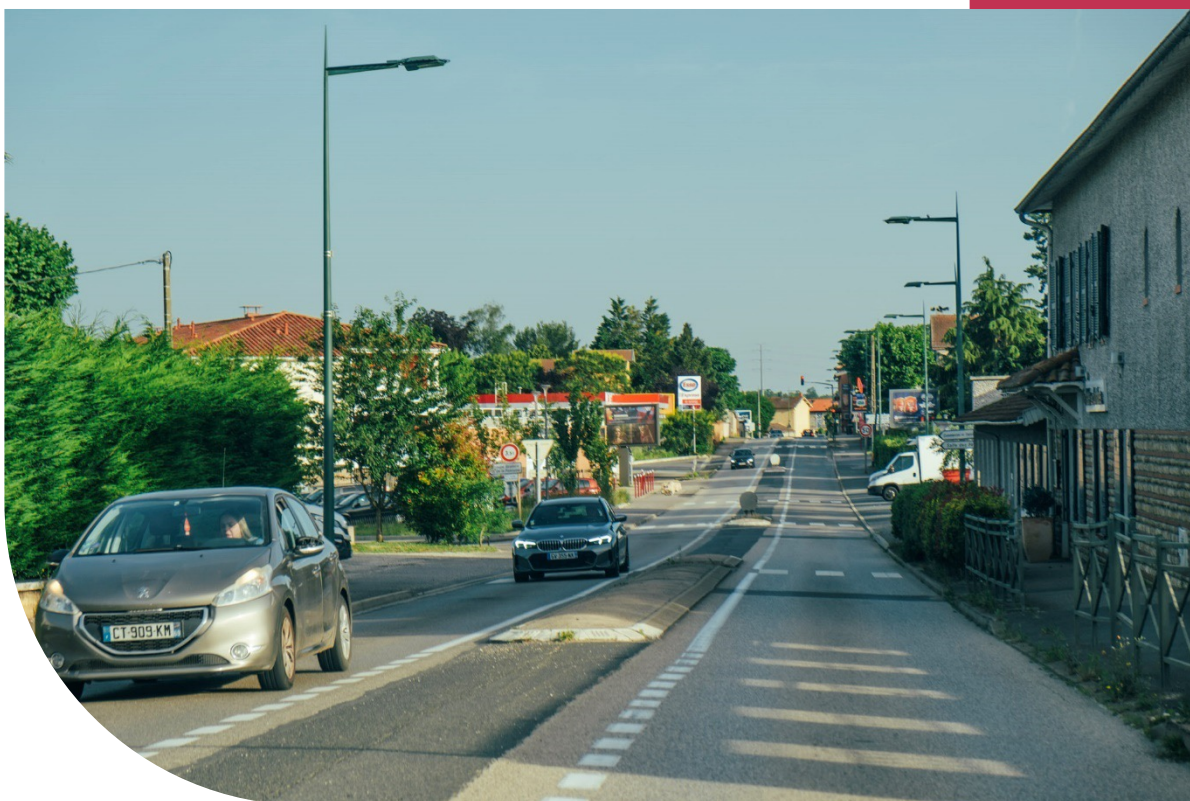
Route de Strasbourg, un axe routier majeur entre Lyon et Bourg-en-Bresse qui traverse de part en part le pôle urbain des Échets.
