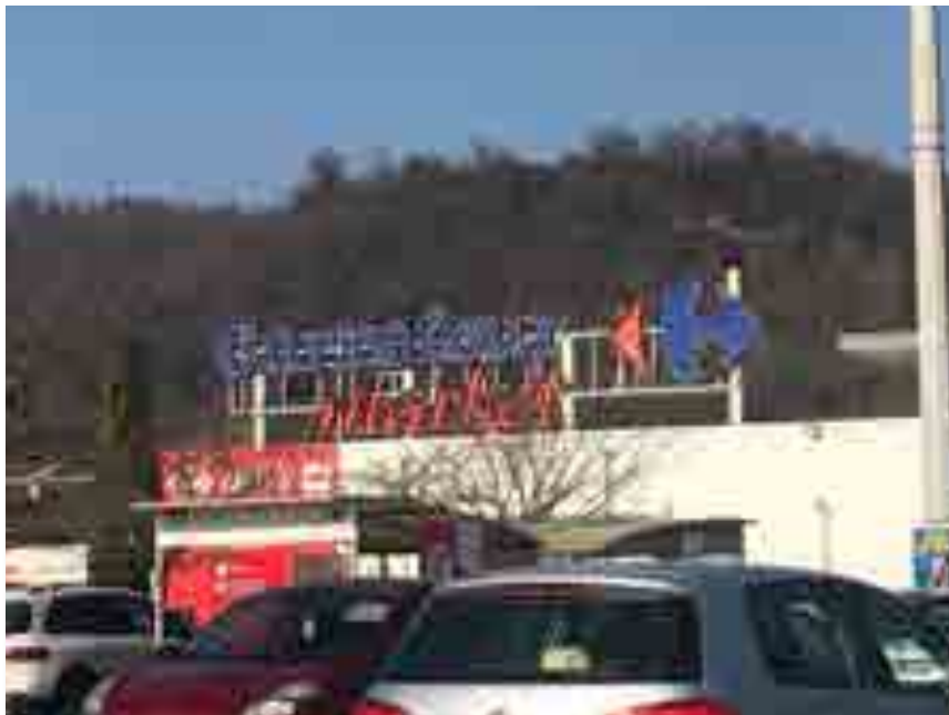
Miribel (structure sur toiture apparente)
