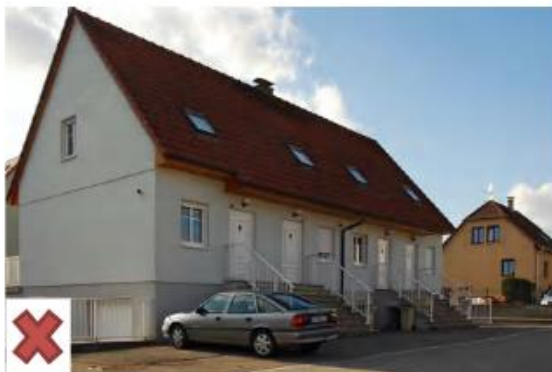
1. Absence de transition
