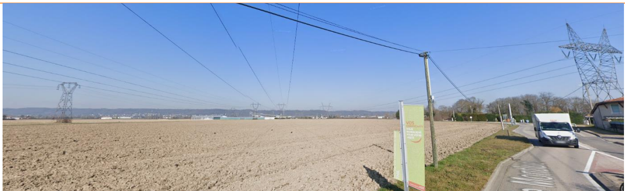
Ligne haute tension au-dessus de la RD61A - Source : googlemaps
